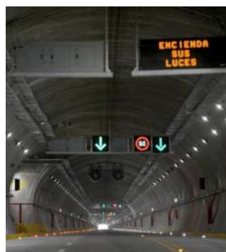
Acatúnel · Entronque Brisamar
